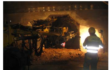
Bilder aus dem Tunnelbau
