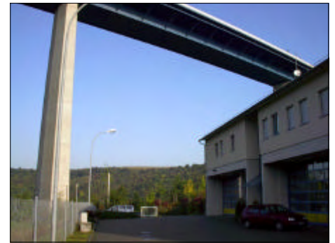
Schwingungsimmission unter Autobahnbrücke
